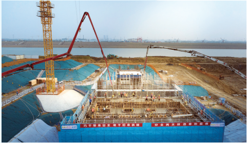
淮河入海水道二期工程淮安境内宋湖站在浇筑站身结构
