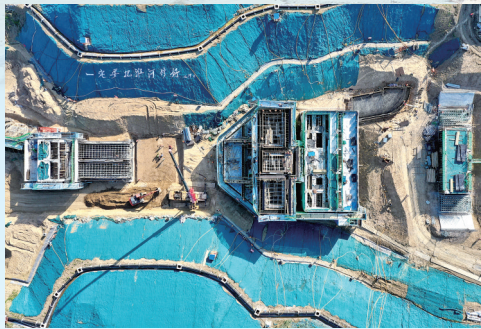
淮河入海水道二期工程淮安市境内和平南站施工现场
