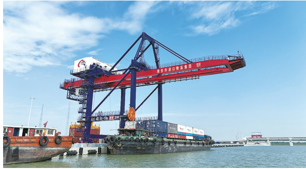
淮安港危化品码头吊装运行
